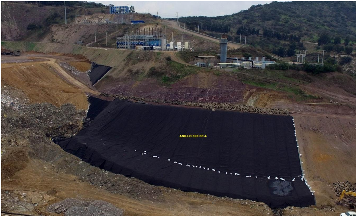
Fotografía 3 – Instalación Geosintéticos Etapa Etapa 590 S-E4
