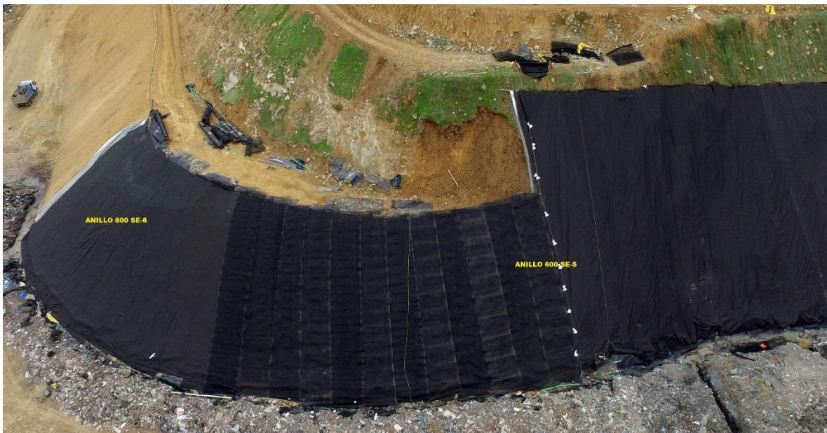
Fotografía 4 – Instalación Geosintéticos Etapa Etapa 600 S-E5 y 600 S-E6
