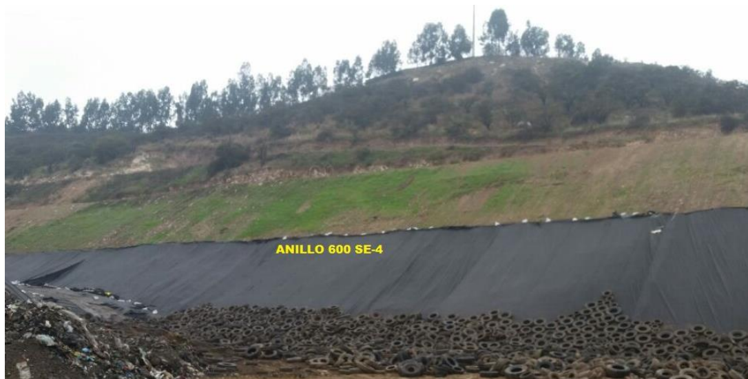
Fotografía 2 – Instalación Geosintéticos Etapa 600 S-E4
