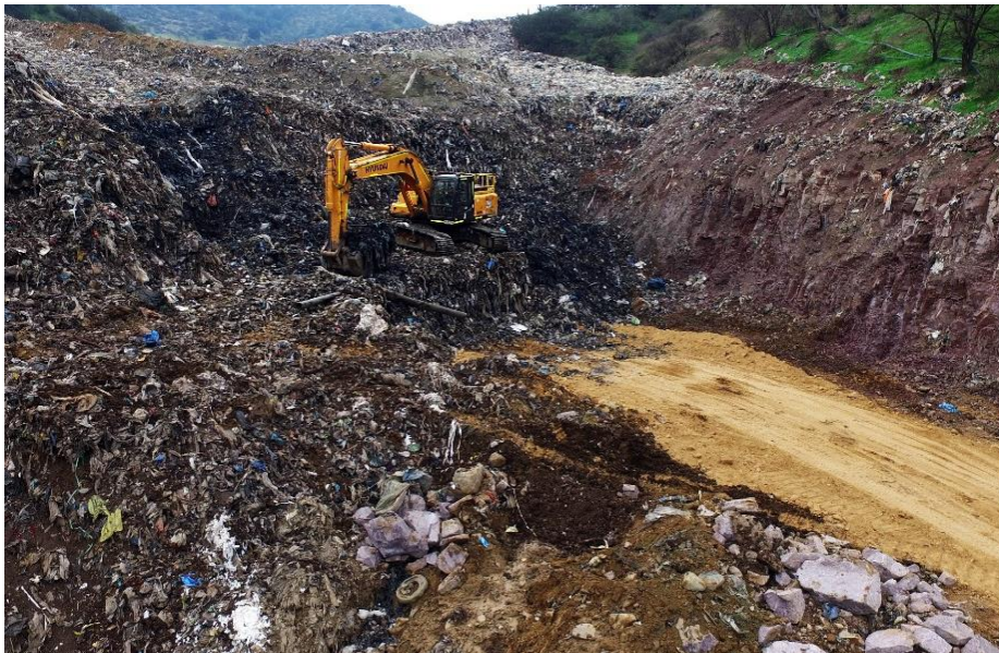
Fotografía 9 – Levantamiento de residuos Quebrada El Boldal
